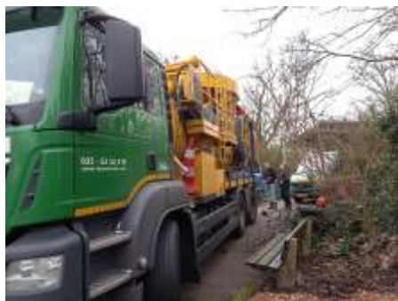
Groot materieel om de problemen op het voorplein bij de toiletten te verhelpen. Foto's Sjoeke
