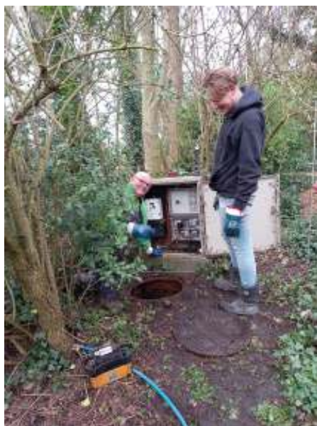
Het rode lichtje brandt voorlopig niet meer want de put is leeggezogen en er is een nieuwe ketting ingezet. Alles is schoongespoeld, dus de klus is geklaard. Nu zijn er hopelijk geen overstromingen meer bij de toiletten!
