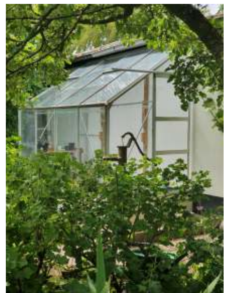
Kas is geheel hersteld door de bouwcommissie.
