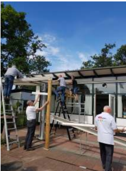
De mannen van de Bouwcomm. mogen onder voorwaarden weer aan het werk: de terrasoverkapping wordt opnieuw geplaatst. De eerste versie bleek niet aan de eisen van de "schoonheidscommissie" te voldoen. De stoel van Leo Pel, zwart shirt, is niet helemaal volgens de regeltjes...
