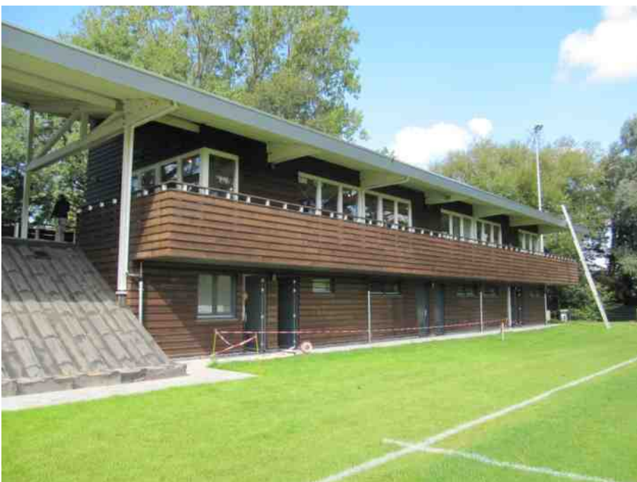
Op 29 september wordt het nieuwe clubhuis van de Rugbyclub Haarlem officieel geopend. De buitenwanden van dit prachtige gebouw zijn gemaakt van duurzaam bamboe. In de ruimte van de scheidsrechters is een invalidentoilet ingericht waar ZWN in voorkomende gevallen gebruik van mag maken. DS
