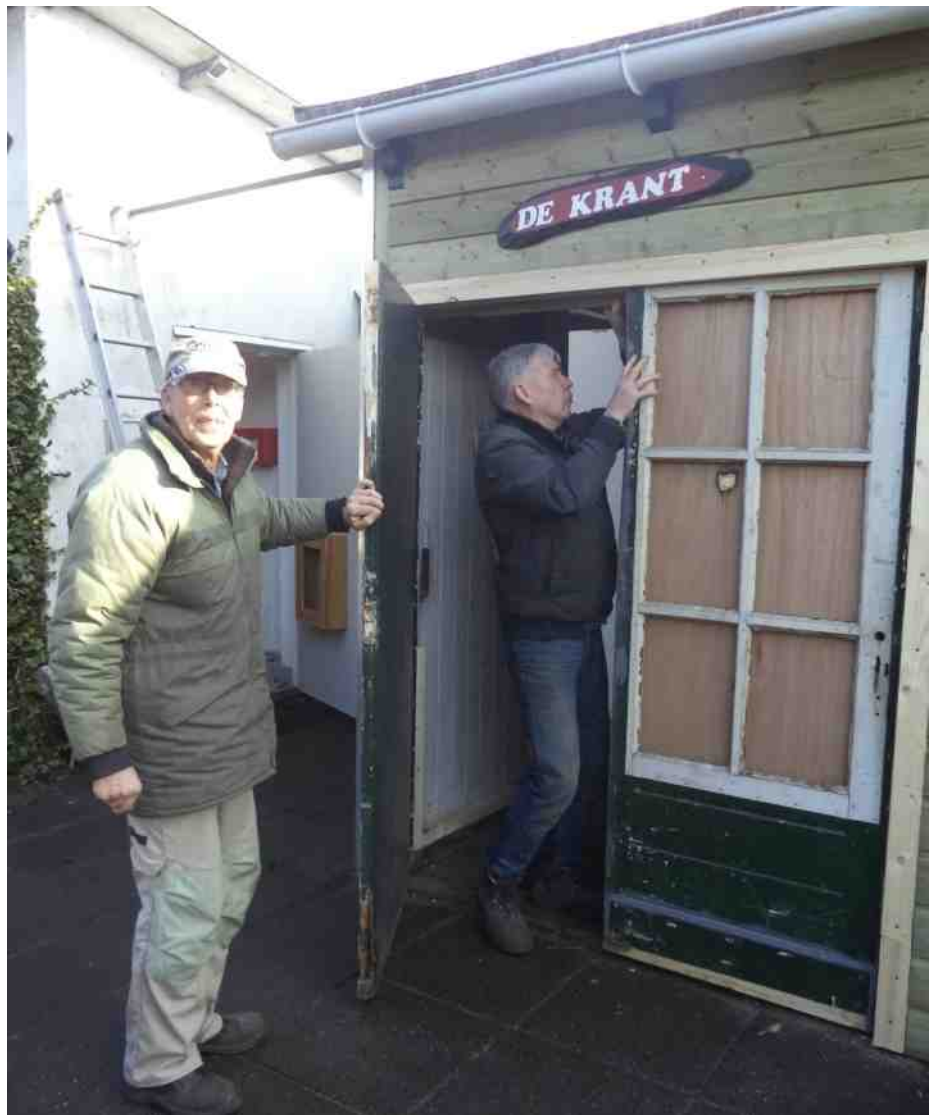
Twee hoofdrolspelers bij de renovatie-activiteiten op het Henstraplein: Flip Henstra en Bert Mooijekind. Flip vanwege een belangrijke donatie en Bert om zijn bouwkundige initiatieven en niet aflatende werklust. Naast "De Krant" werd ook de winkel-entree aangepakt. Lees meer op blz. 7 en 8. Foto DS
