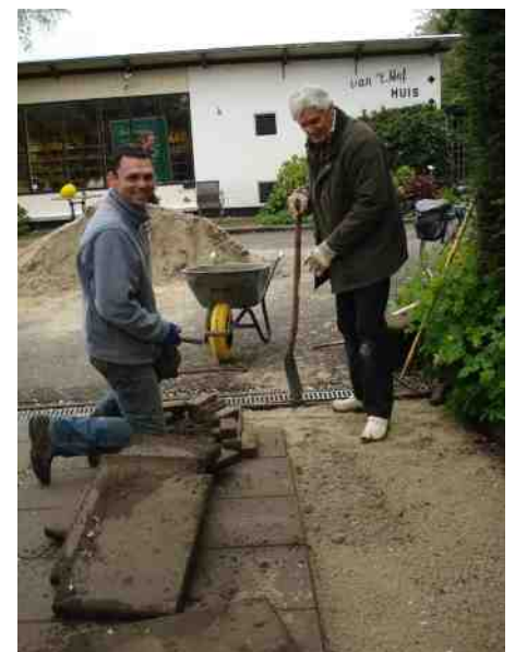
Bijna elk jaar verrast de gemeente ons met een berg zand. In ons wegzakkende poldertje kunnen we dat goed gebruiken! Tijdens Algemeen Werk wordt hier het oprijpad naar de loods opgehoogd. Foto Sjoeko
