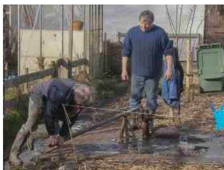
Het slaan van een bron voor een pomp. Foto HvD
